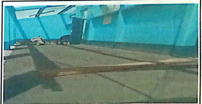
Foto 6: Sustitucion de Piso
